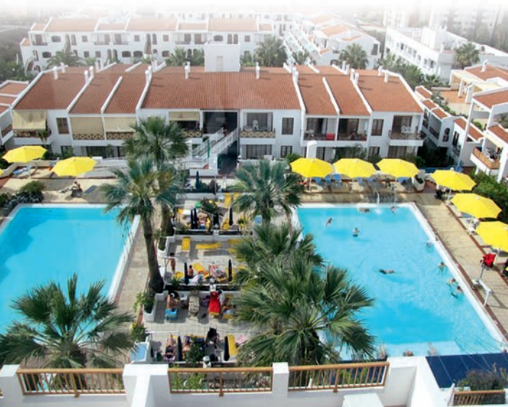
Blick auf die Anlage.
